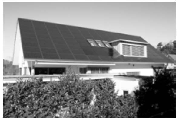
SOLTOP Energiedach mit PV-Modulen (Strom), Kollektoren (Wärme), Blindelementen und Einbindung von Dachfenstern
