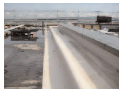
Vorgängig erstellte Dachrandabschlüsse und Fassadenanschlüsse
