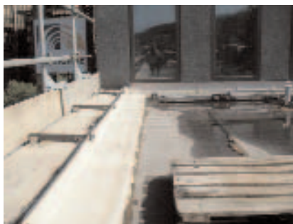
Vorgängig erstellte Dachrandabschlüsse und Fassadenanschlüsse
