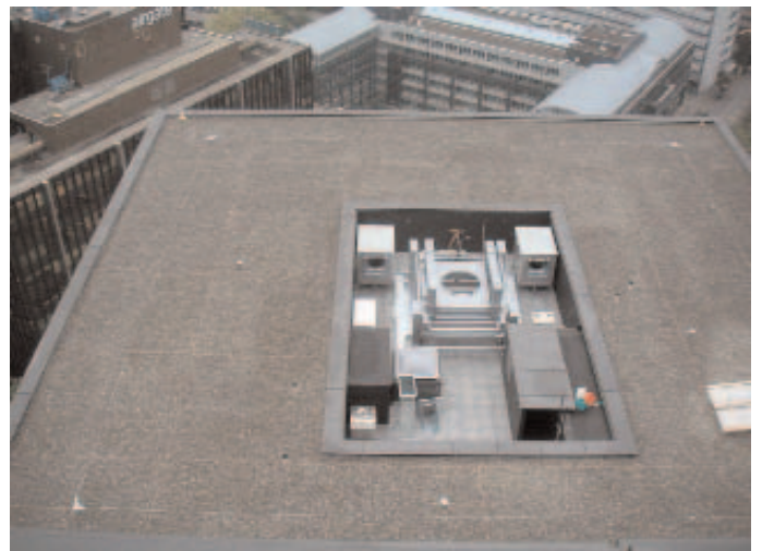
Dachaufsicht untere Dachfläche
